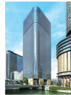
大阪本部 (中之島フェスティバルタワー・ウエスト:大阪市北区)
