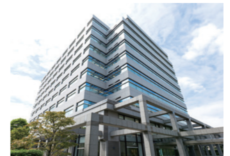
本社(DSBグループ潮見ビル:東京都江東区)
